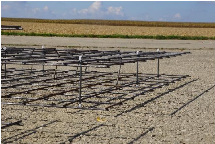
Die Rapperstorfer Korbwand® wird automatisiert in Losgröße 1 produziert. Fotocredit: Rapperstorfer Automation
